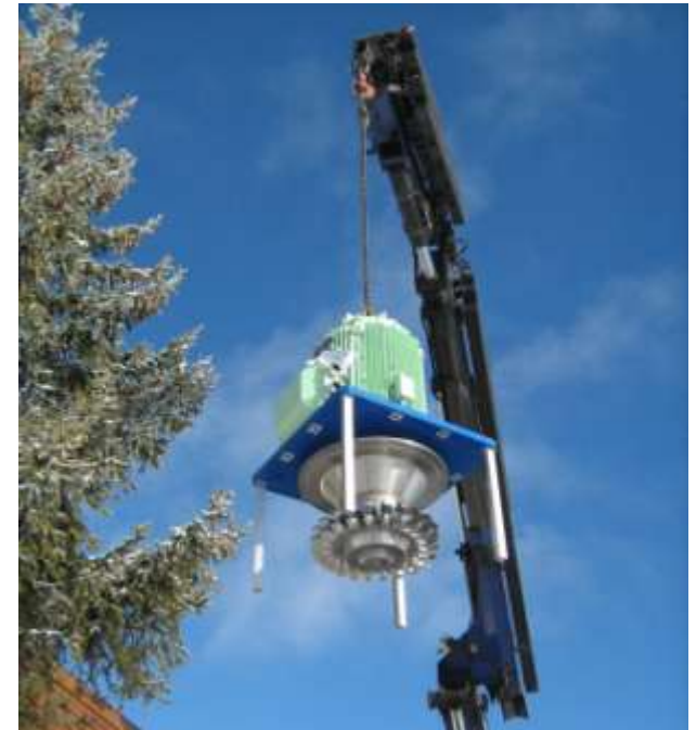
Turbine sur l'eau potable de Lens (Suisse): 40 l/s, 87 m, 30 kW Pelton 1 injecteur (Telsa SA)
